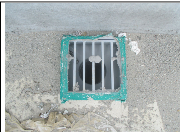
배수구 시공 상태 점검
