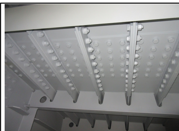
BOX 내부 시공 상태 점검
