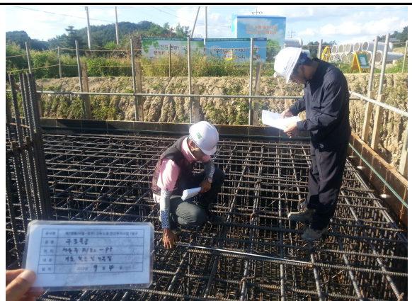
P5 기초 시공 상태 검측
