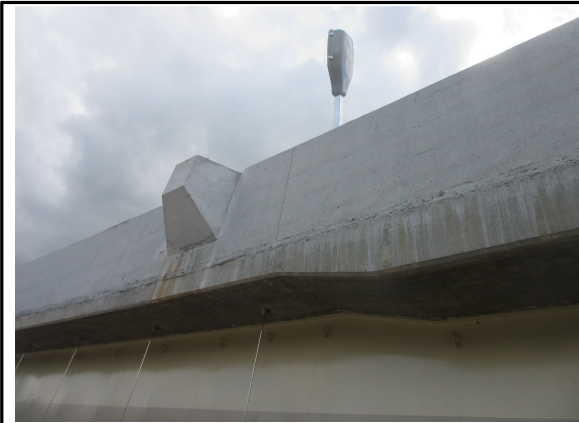
방호벽 외부 시공상태 점검
