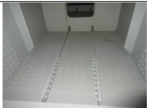
BOX 내부 시공 상태 점검
