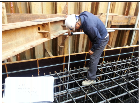
P6 기초 시공 상태 검측
