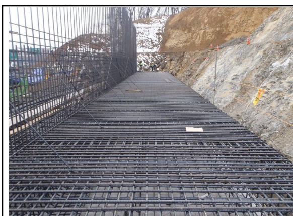
A2 기초 철근 조립 상태
