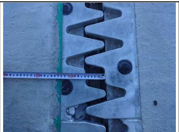
신축이음 A2 유간 측정
