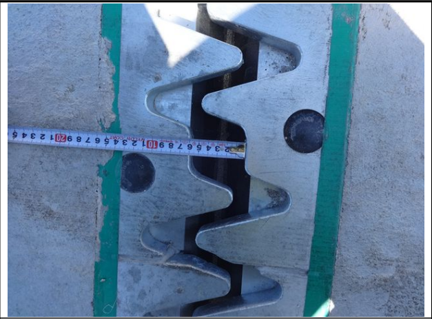
신축이음 A1 유간 측정
