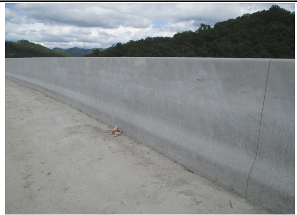
방호벽 시공 상태 점검
