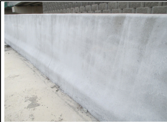
방호벽 시공 상태 점검
