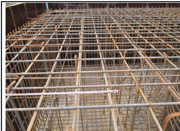
P5 기초 철근 배근 상태
