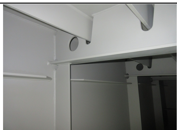
BOX 내부 시공 상태 점검
