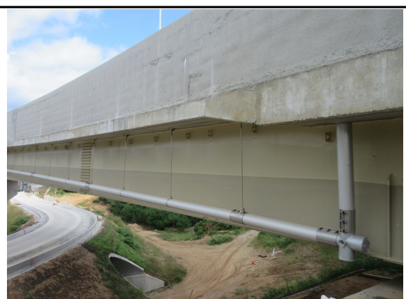
배수관 시공 상태 전경
